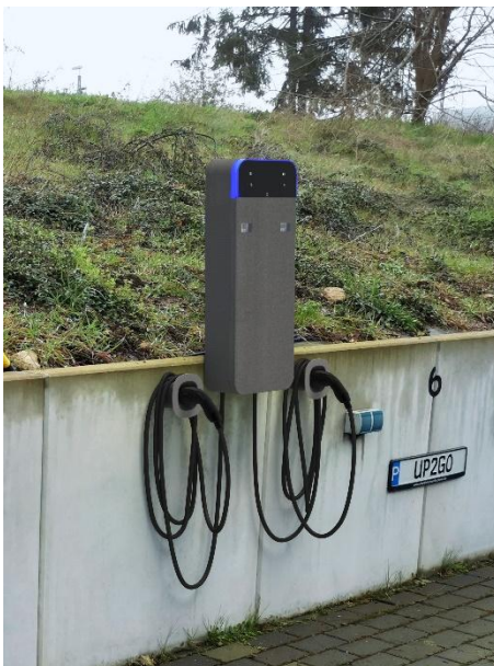
Beispielhafte Montage der Steckeraufnahme neben einer wandmontierten LADEplus
